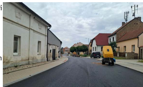
Práce na průtahu Chýnín.
